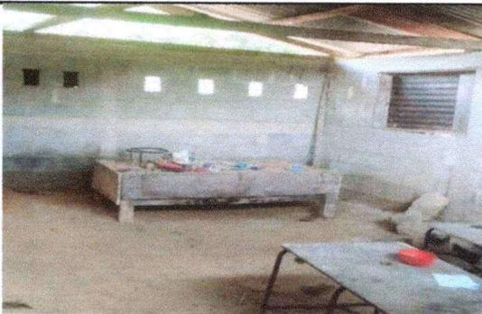
**Foto 5: Se observa la necesidad de sustituir la estructura de madera actual por estructura metálica modulo 2; así mismo la necesidad de cernido**
