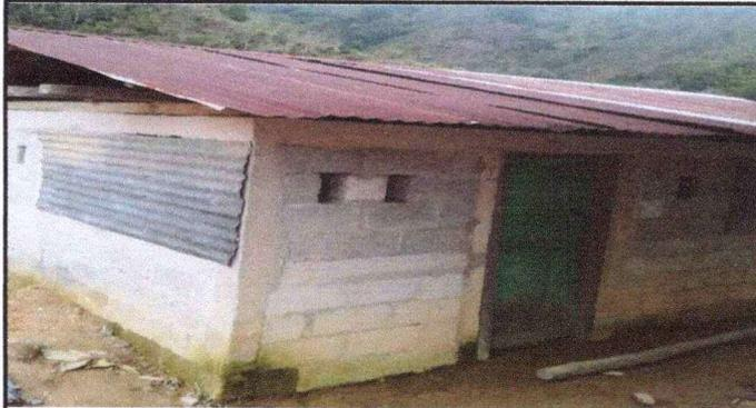
**Foto1: Se observa el deterioro de la cubierta de lámina del modulo 2 y cernido de paredes**
