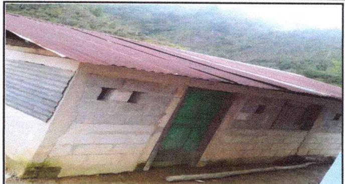
**Foto 2: Se observa la necesidad de puertas y ventanas modulo 2**
