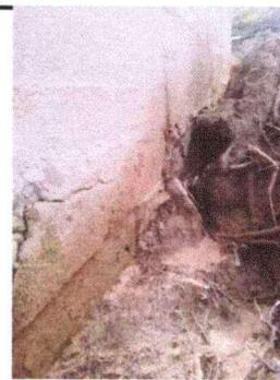
**Foto 6: Se observa la necesidad de reforzar la cimentación del modulo 2**
